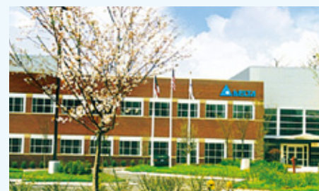
北卡罗莱纳州电力电子研发中心
